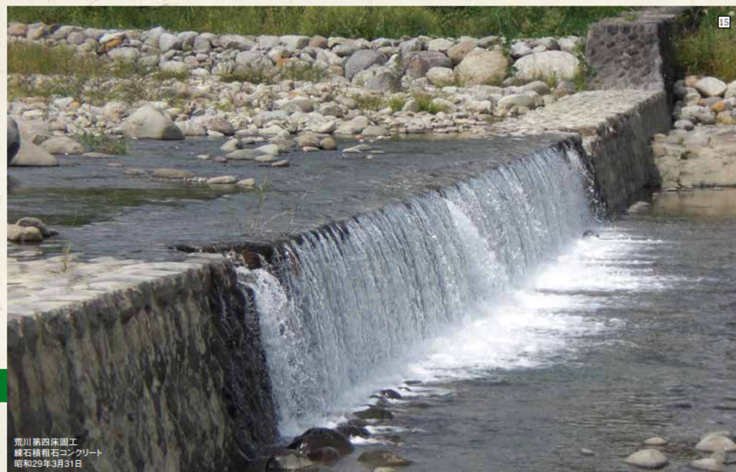
荒川第1床固工 練石積粗石コンクリート 昭和26年3月31日
