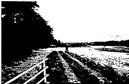
上名倉地区破堤状況
