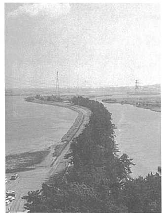
○油島千本松原： 揖斐川・長良川（岐阜県）
